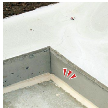
コンクリート打継部
