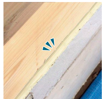
土台と基礎間
